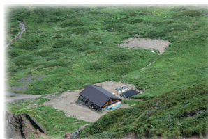
(写真26) 完成した小屋と 公衆便所撤去跡(右上)
