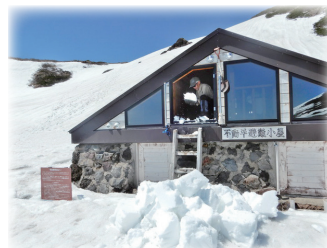
(写真25) 冬期出入口への吹込み雪排雪
