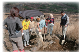
(写真28) 登山道の水切り設置
